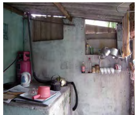
黒いパイプで雨水を直接引いている。食器洗い、体を洗うのに使う。水槽にも雨水をためている
