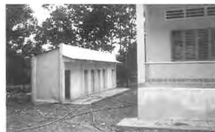
新設された屋外トイレ(左)
