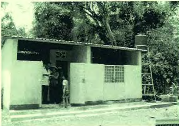
完成したトイレと水タンク（奥）
