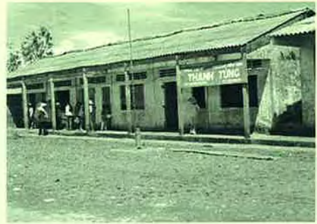
タントン小学校外観
