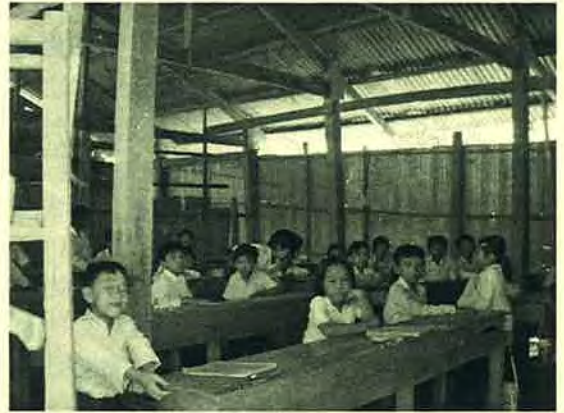
教室はトタン屋根で、板塼で周囲を囲っている。
